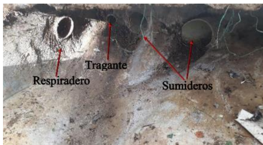
Foto 9. Caja de inspección adyacente al cuarto de la planta de emergencia.
