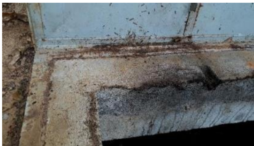
Foto 13. Tapa de acceso al tanque.
