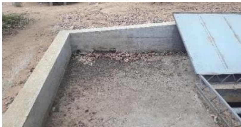
Foto 16. Reforma del cuarto de bombas.
