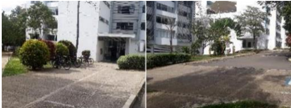
Foto 6. Zona frontal del edificio E3T
