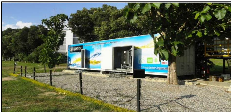
Figura 7. Container reactor de cavitación hidrodinámica foto 2 (HCR-200-2)
