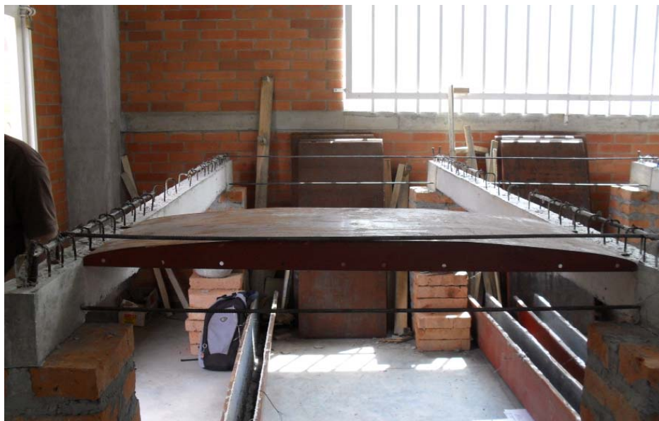
Figura 23. Instalación de formaletas para fundir entrepiso.
