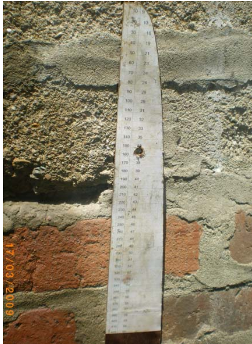
Figura 11. Lamina delgada de acero se utilizo como guía de corte.
