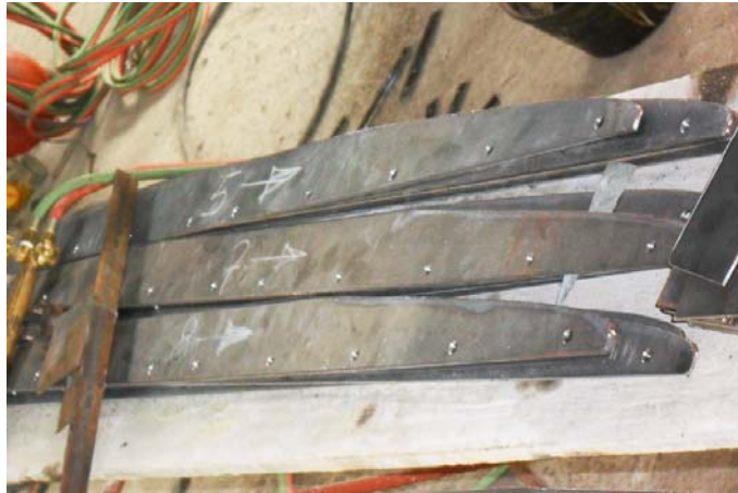
Figura 14. Láminas cortadas y perforadas para construir el encofrado.
