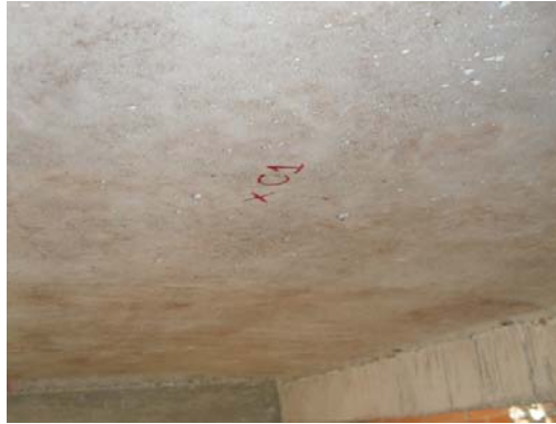
Figura 54. Marca para ubicar el deformimetro
