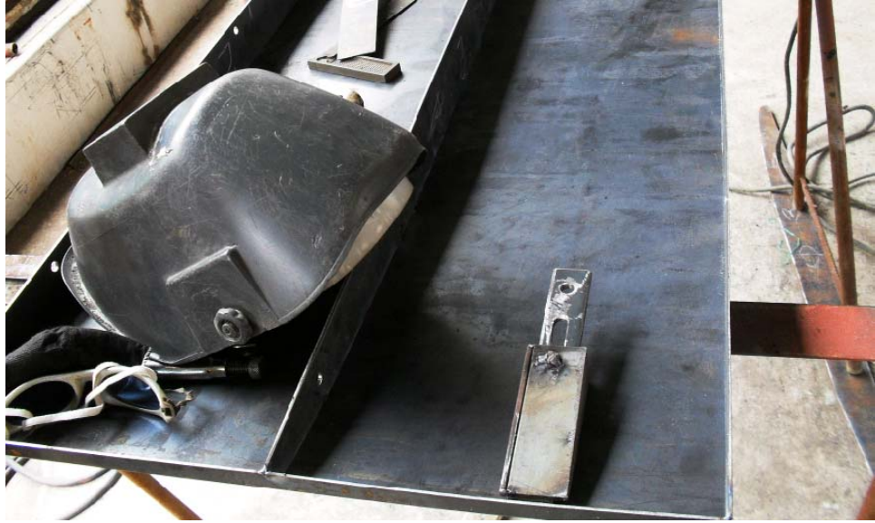
Figura 21. Soldadura de pasadores a la estructura del encofrado.
