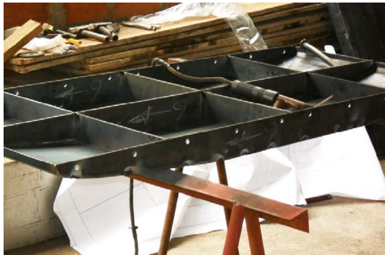
Figura 19. Soldadura rigidizadores transversales del encofrado.
