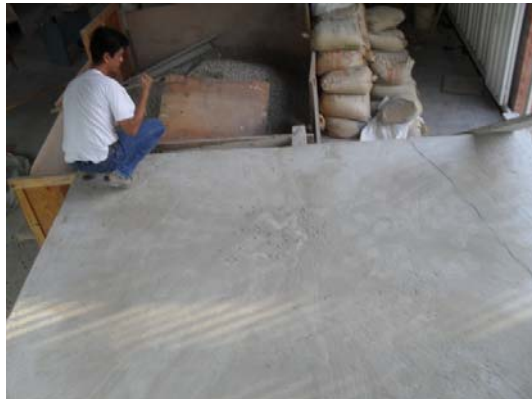
Figura 59. Descarga de placa para medir la deflexión residual.
