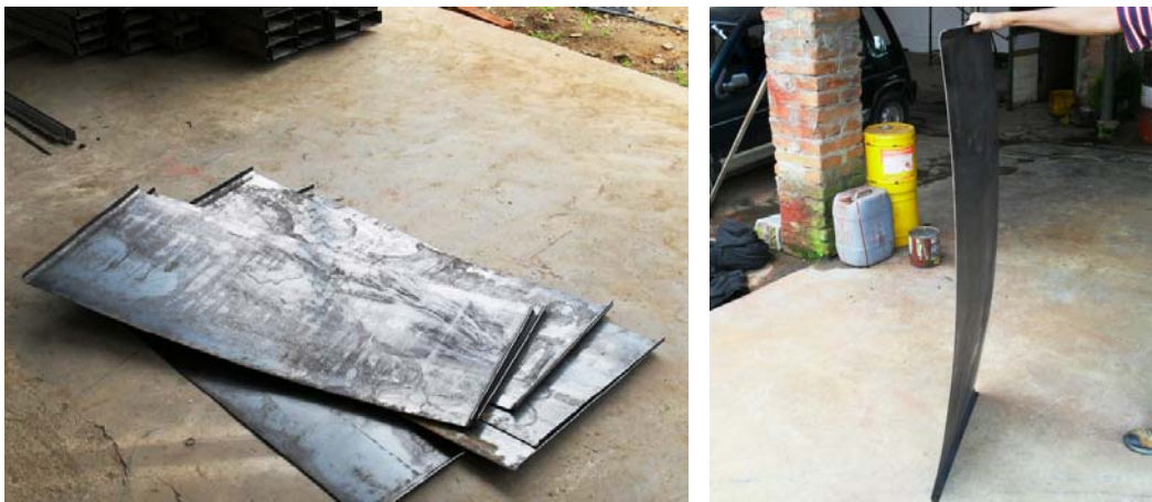
Figura 15. Láminas que se utiliza para dar la forma curva del encofrado.
