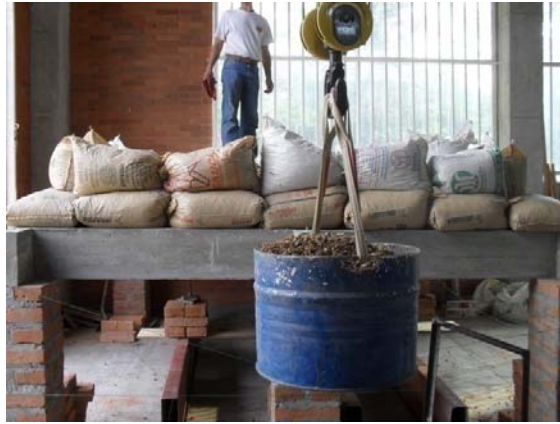
Figura 57. Levantamiento de carga con ayuda del puente grúa.
