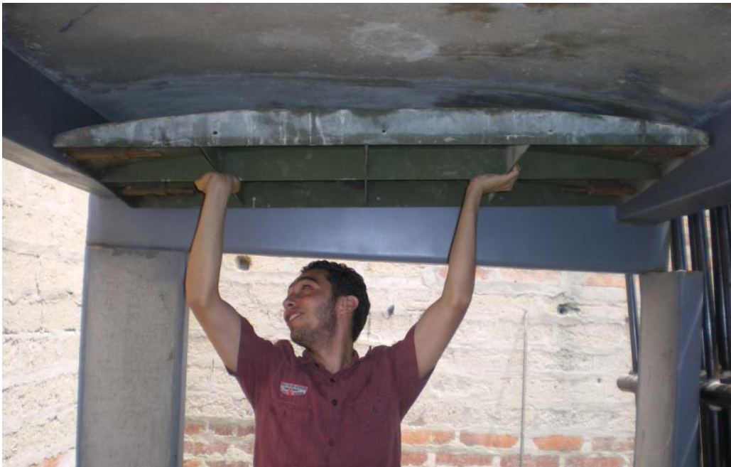
Figura 22. Desencofrado.
