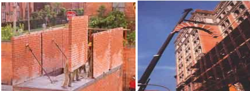
Figura 7. Colocación de mampostería prefabricada.
