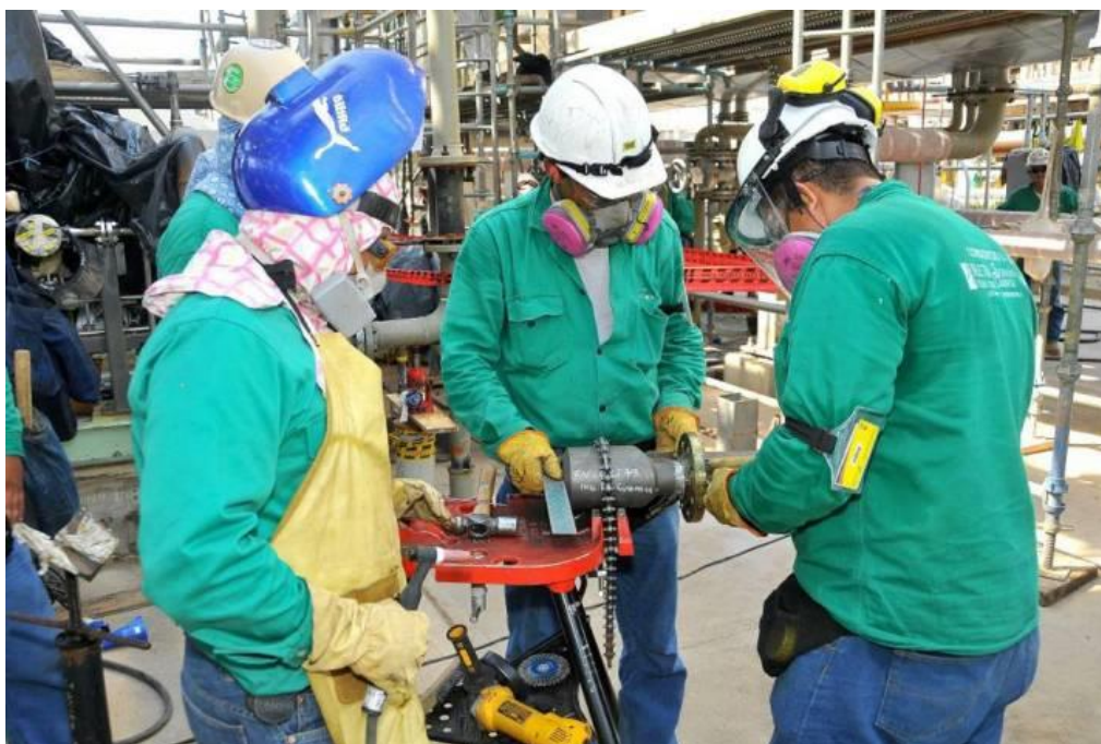
Figura 5. Trabajadores realizando operaciones en tubería, Refinería de Barrancabermeja.
