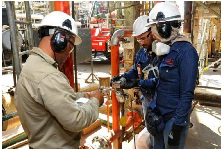
Figura 6. Trabajo en tubería parada de planta U-200.
