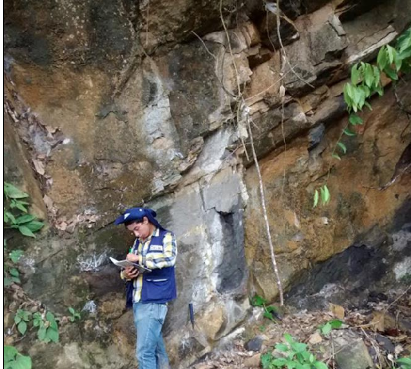
Fotografía 2. Bancos de calizas alternando con capas delgadas de lodolitas calcáreas. Estación UF8V-R06 K101+092.
