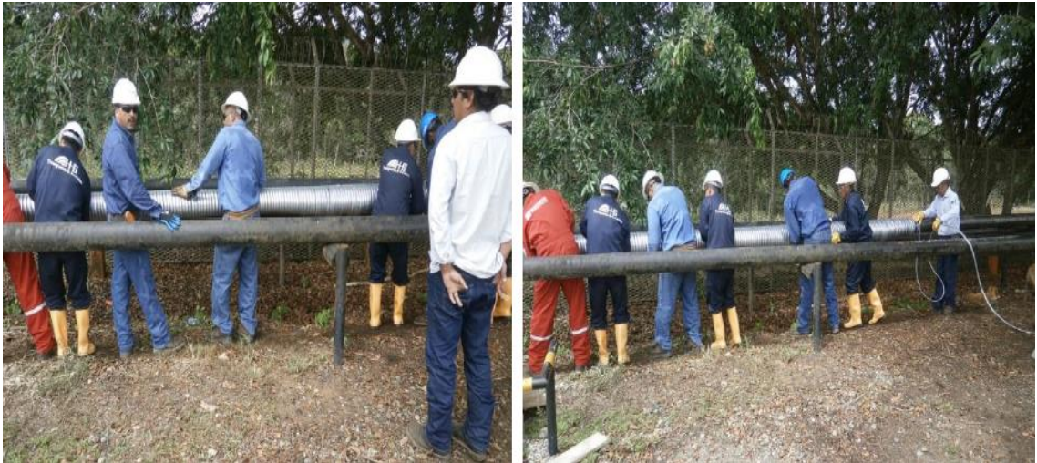
Figura 29. Instalación del cable calentador (Cableado)
