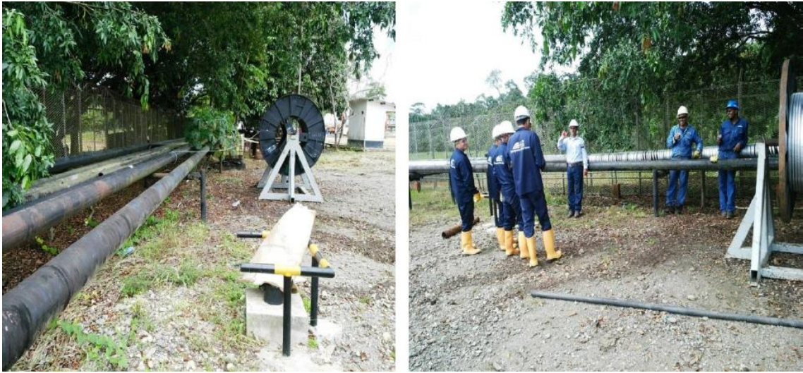
Figura 28. Instalación del cable calentador (Tubería)
