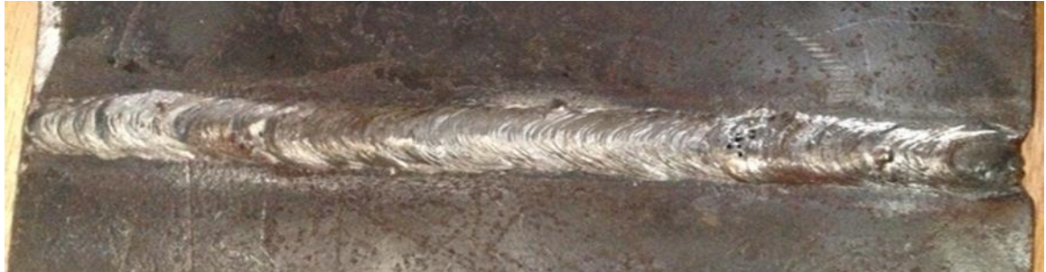
Figura 6. Vista de interés de la muestra P1.
