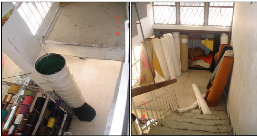
Figura 13. Vista superior de la plazoleta
