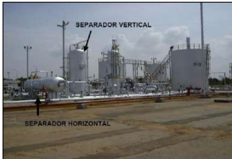
Figura 7: Separadores en facilidad Petrolera.
