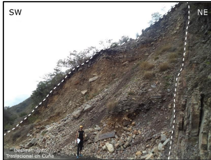
Figura 79. Deslizamiento traslacional en cuña (Dtc). (JR-I10). Producto del alto buzamiento y fracturamiento de las rocas de la Formación Aguardiente (Kia) localizado en la Vereda Puertas del Municipio de Enciso.
