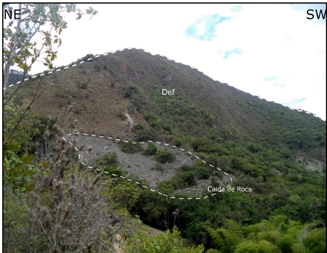
Figura 64. Escarpe faceteado (Def). Localizado en la Vereda Villeta del Municipio de Enciso, en su base se presenta un depósito coluvial producto de la caída de roca (Cr) de material clástico cementado correspondiente a la Formación Aguardiente.
