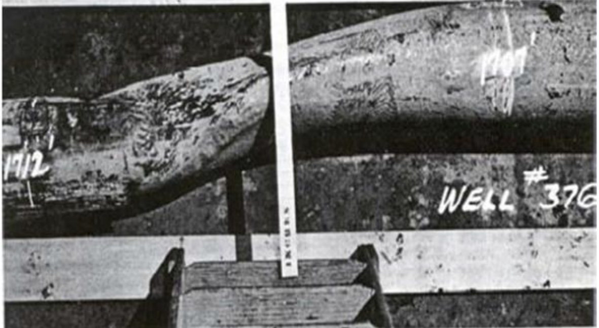
Figura 40. Deformaciones y erosiones en la tubería
