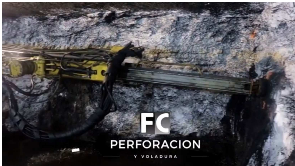
Figura 19. Proceso de Perforación sobre el manto.
