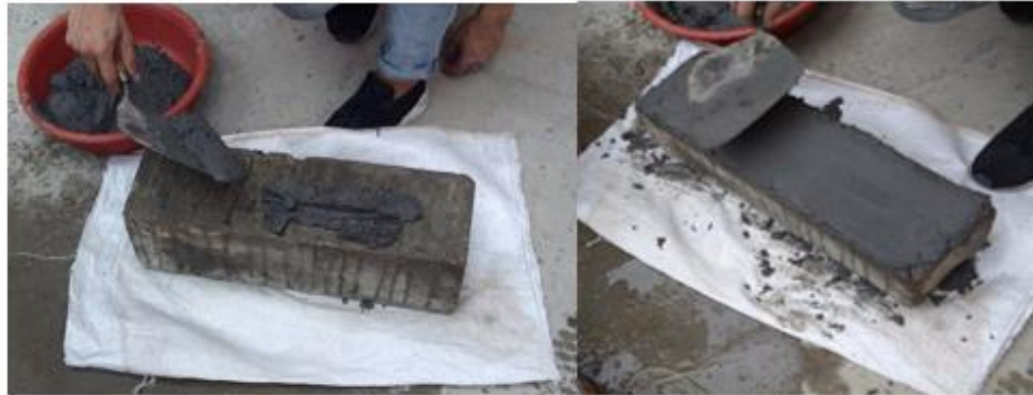
Figura 6. Aplicación Primera Capa de Mortero
