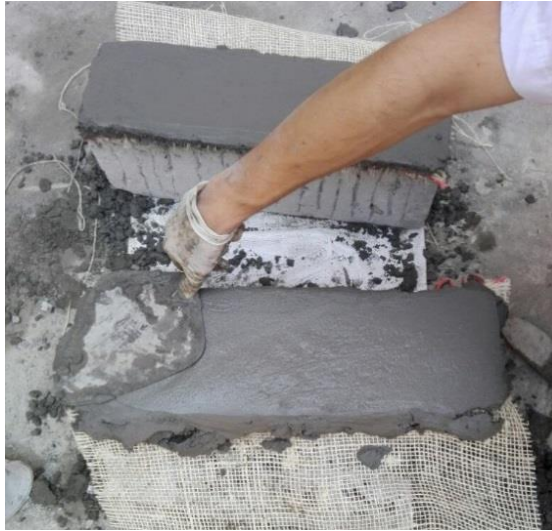
Figura 8. Aplicación Segunda Capa de Mortero
