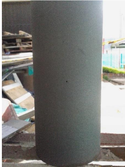
Figura 32. Tubería después del granallado.
