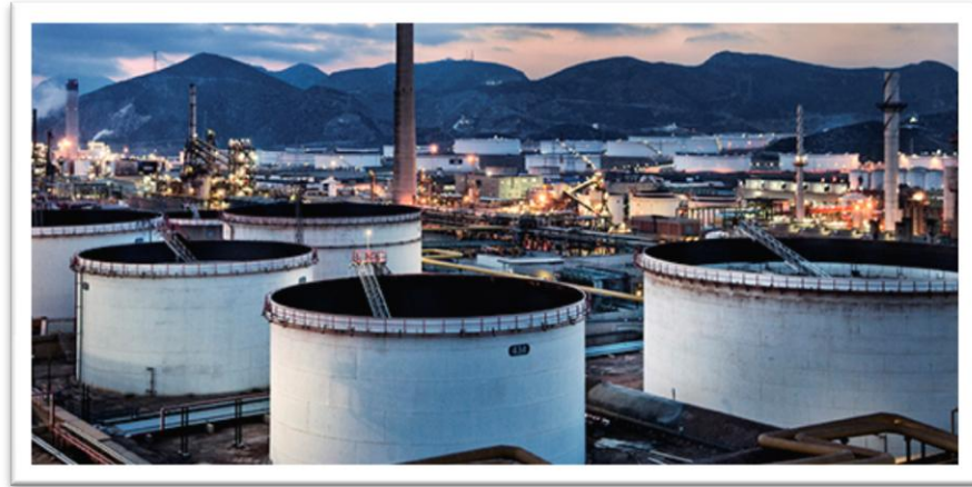
Figura 7. Tanques de Almacenamiento sin Techo
