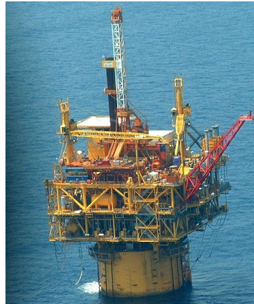
Figura 10. SPAR, Adaptado de Sector marítimo, las plataformas petrolíferas que operan a mayores profundidades. Por © 2016 Copyright Revista de Ingeniería Naval.
