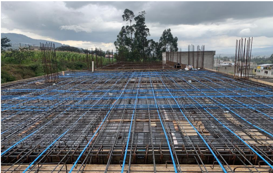
Ilustración 2. Losa de entrepiso en postensado.
