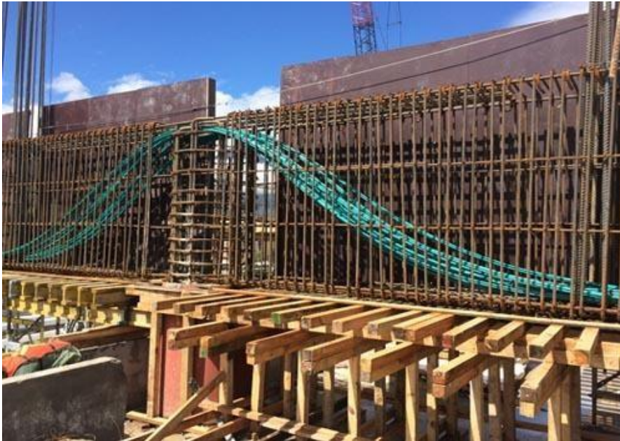
Ilustración 1. Viga en postensado
