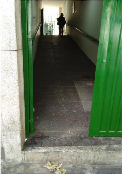
**Imagen 18. Vista frontal del modelo de rampa adecuada como salida de emergencia.**
