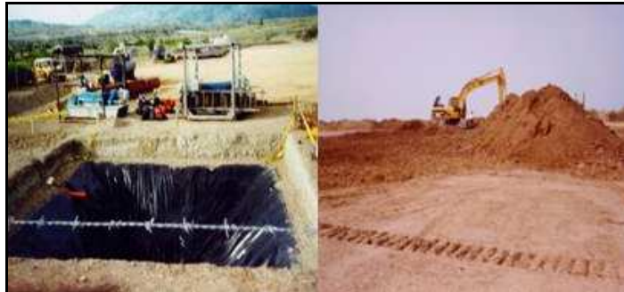
Figura 25. Localización de un pozo y construcción de vía de acceso
