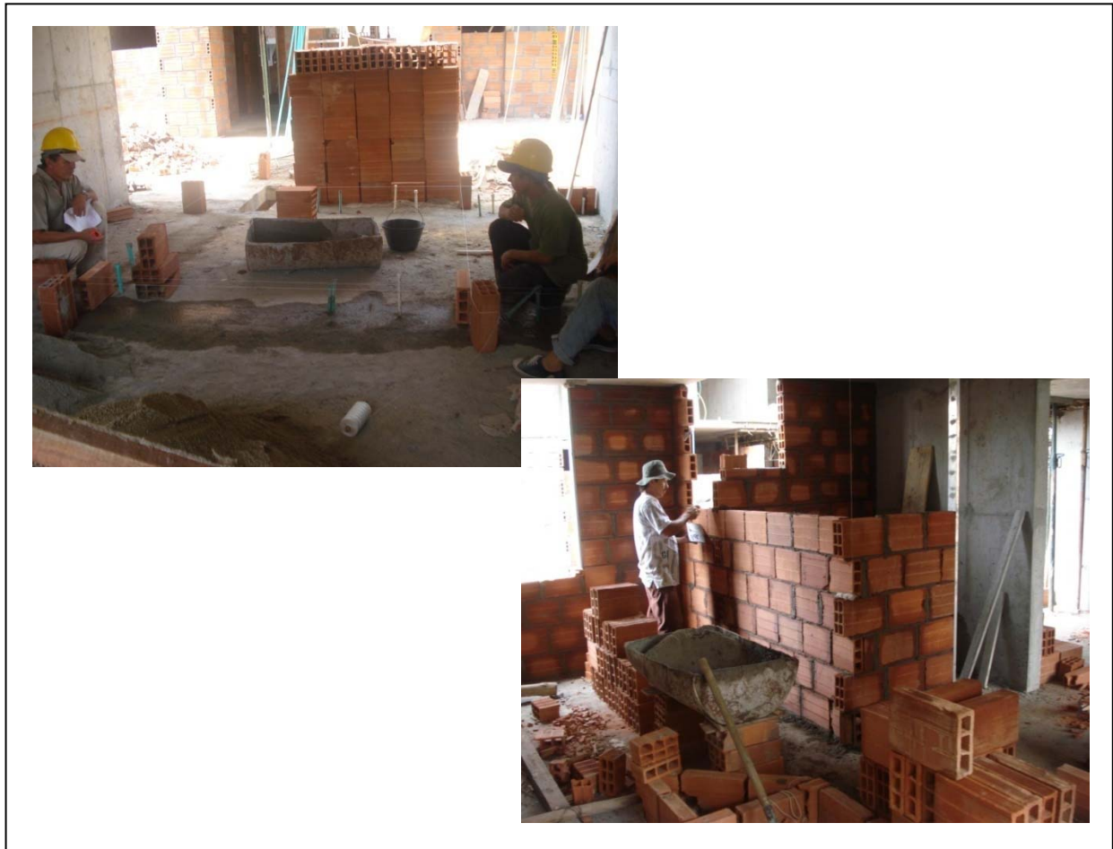
Actividades y Tareas. Proceso Mampostería.
