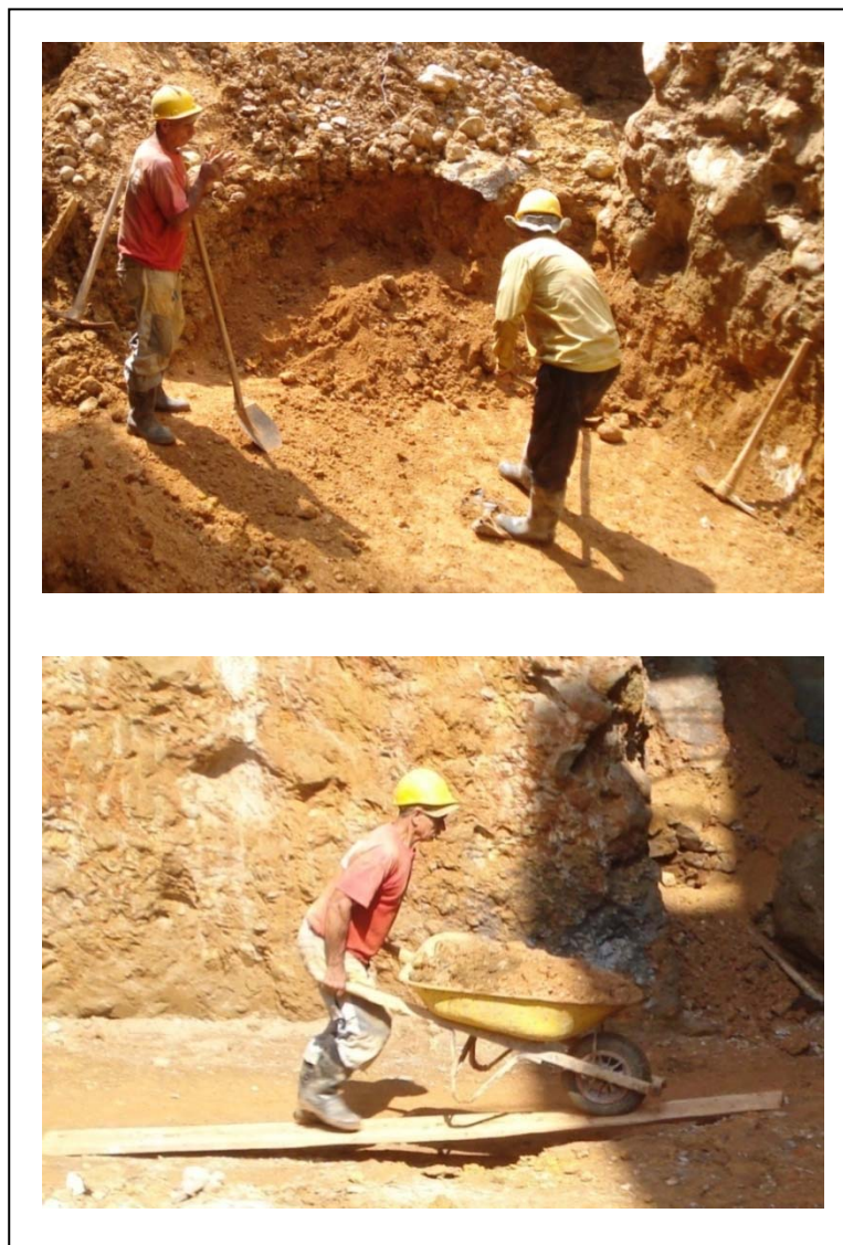
Figura 6. Actividades y Tareas. Proceso de excavación.
