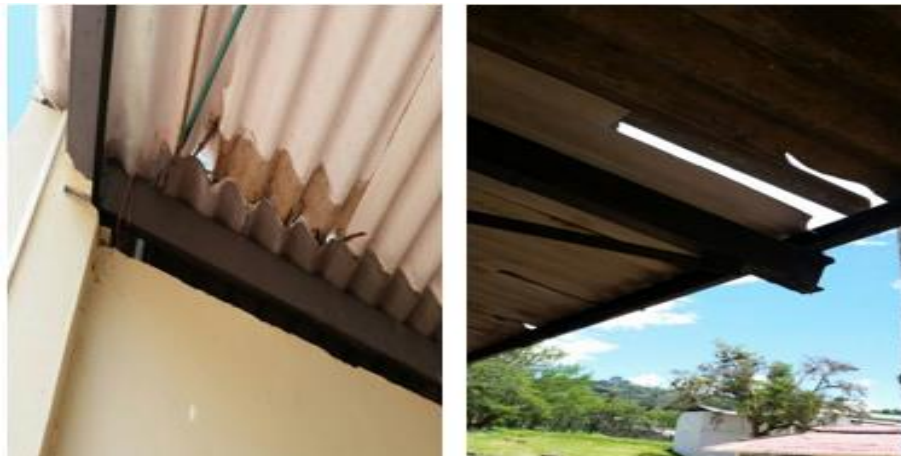
Figura 4. Daños observados en las cubiertas de los alojamientos de tropa.
