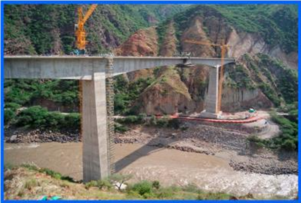
Ejes 3 y 4 Puente Vehicular
