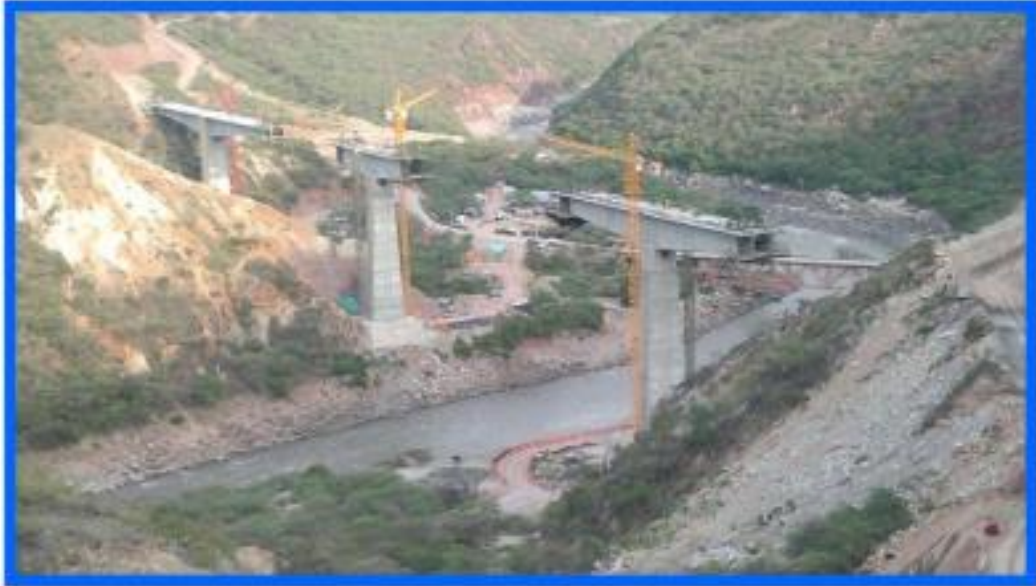
Construcción de Dovelas Entre Ejes y Estribos
