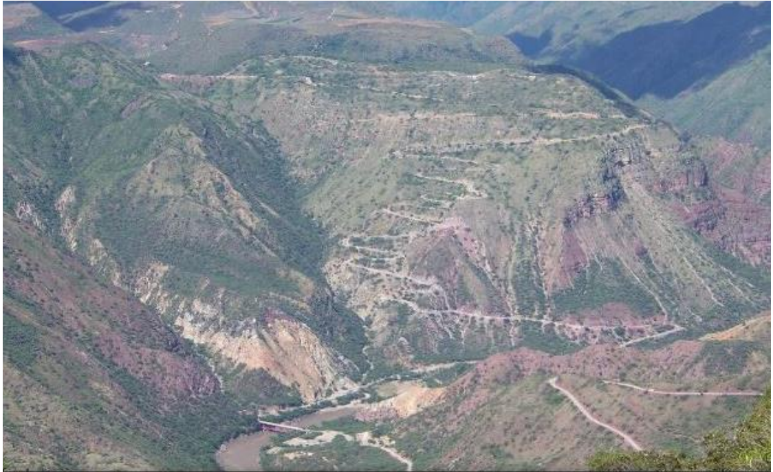
Figura 2. Ubicación General del Puente Vehicular
