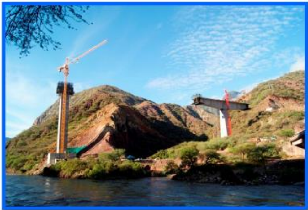
Columnas Eje 3 y Eje 2
