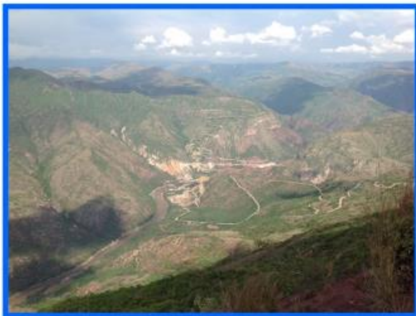
Ubicación General Puente Vehicular
