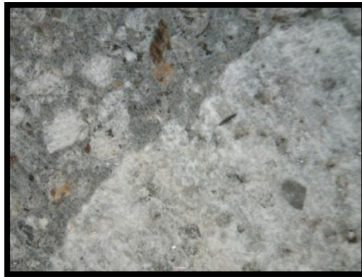
a) Corte sin afectación por fuego (17x)
