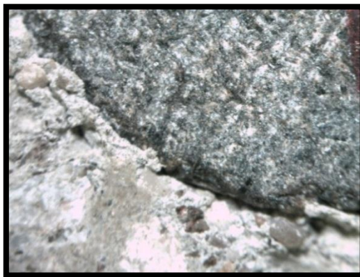
c) Grieta limite agregado-mortero (17x)
