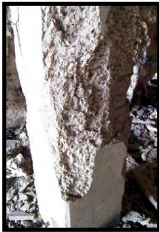
a) Spalling
