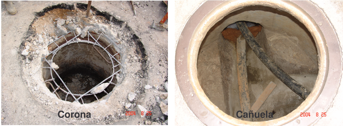
Foto 16. Corona y cañuela en reparación
