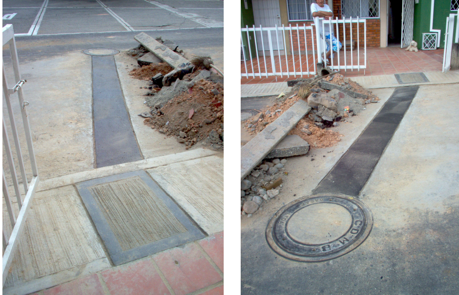
Foto 17. Reparación realizada por MARVALL
