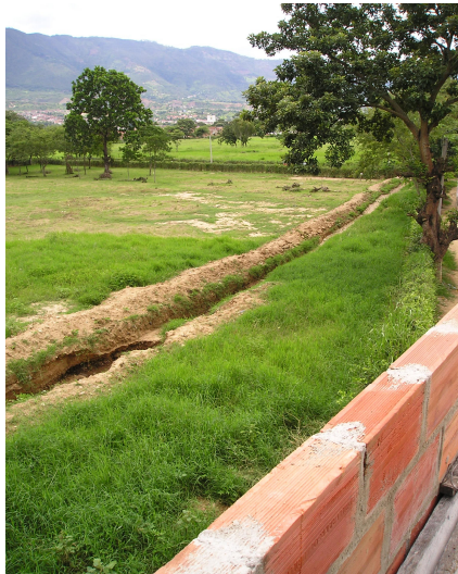
Foto 10. Zanja construida por los habitantes del barrio
