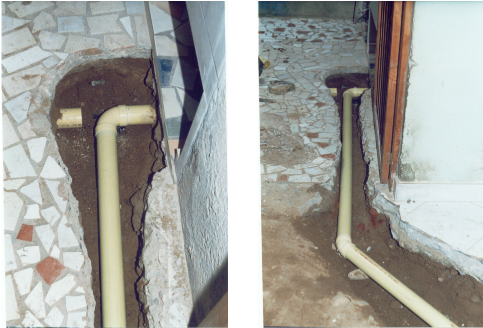
Foto 11. Reparación de conexión errada
