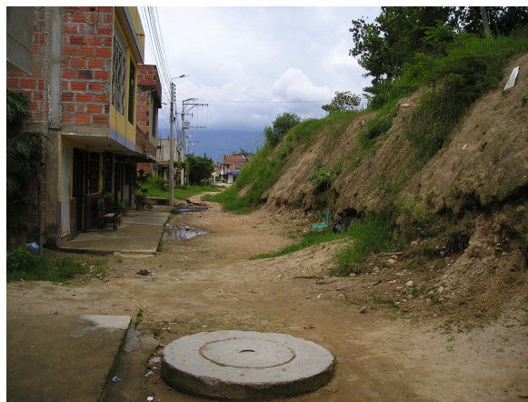
Foto 9. Estado de las calles interiores del barrio
