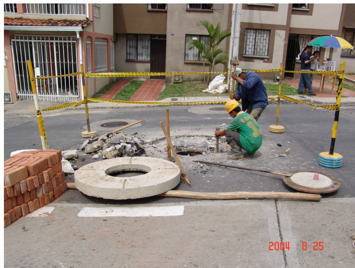
Foto 15. Reparaciones realizadas por personal del Distrito III en el barrio
