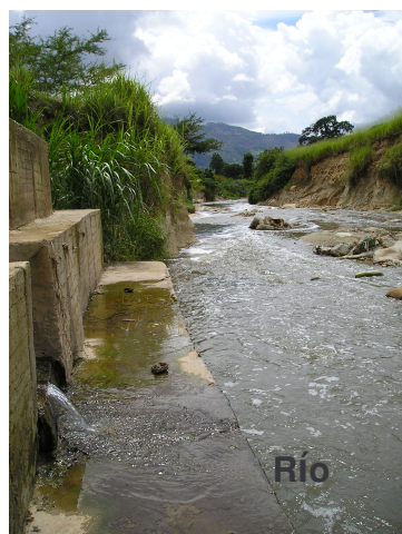
Foto 1. Estructura de entrega pluvial del barrio Villas de Don Juan II etapa al Río Frío
