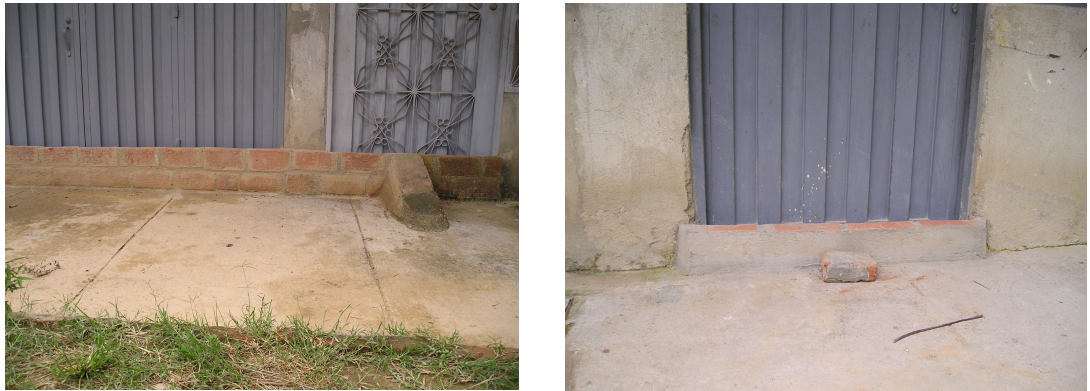
Foto 8. Viviendas que se encuentran ubicadas frente al talud
