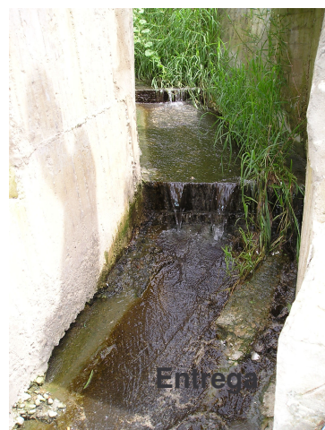
Foto 1. Estructura de entrega pluvial del barrio Villas de Don Juan II etapa al Río Frío
