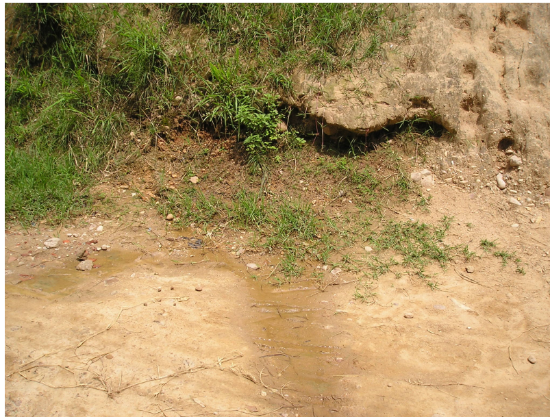
Foto 7. Evacuación de agua por el pie del talud
