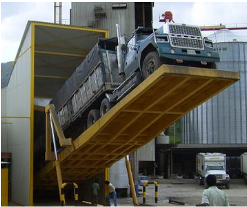
Figura 10. Silos de almacenamiento y volcos de descargue
