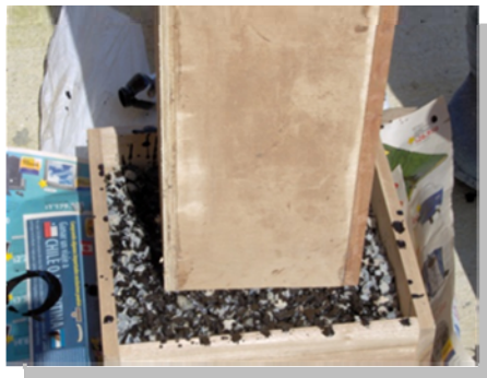
Fotografía 14. Compactación de la Primer Capa
