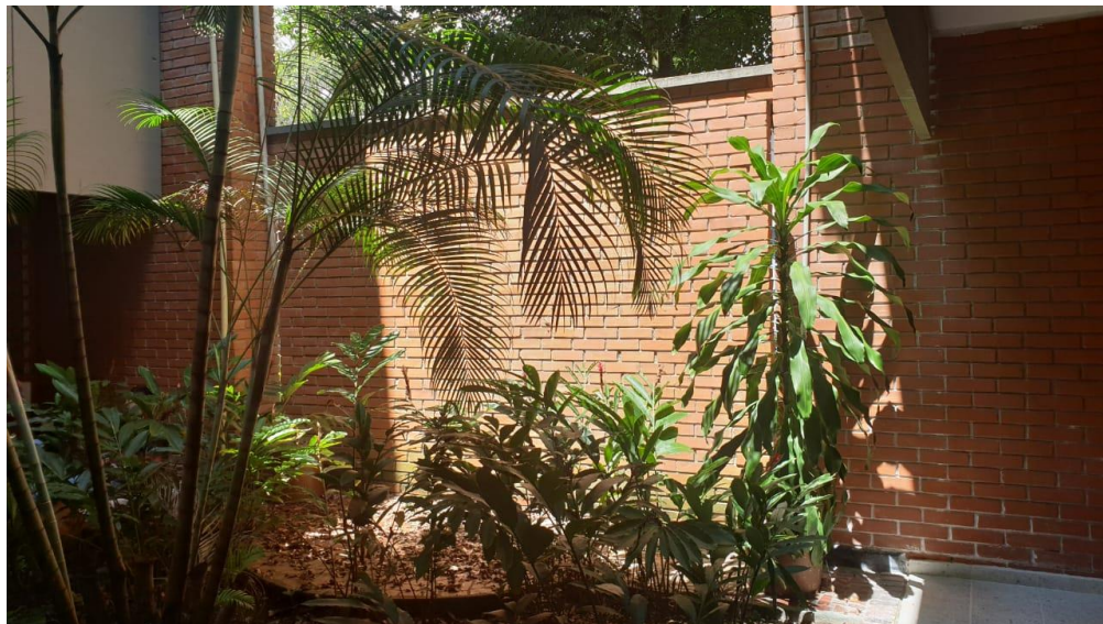
Figura 11. Registro fotográfico del muro a intervenir.
