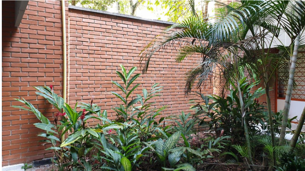
Figura 12. Registro fotográfico del muro a intervenir.
