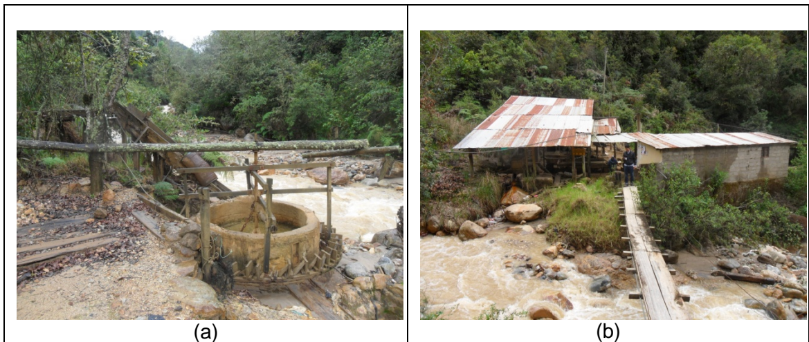
Figura 6. Infraestructura Mina La Plata
