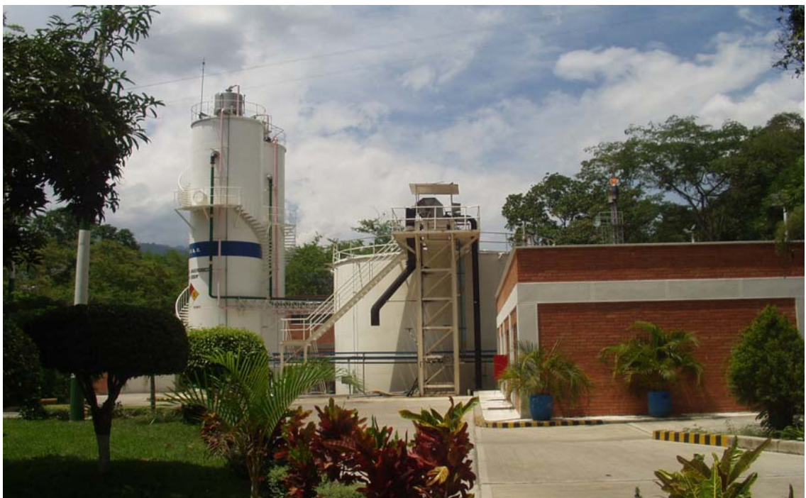
Figura 2. Imagen de la planta de tratamiento Cervecería de Bucaramanga
