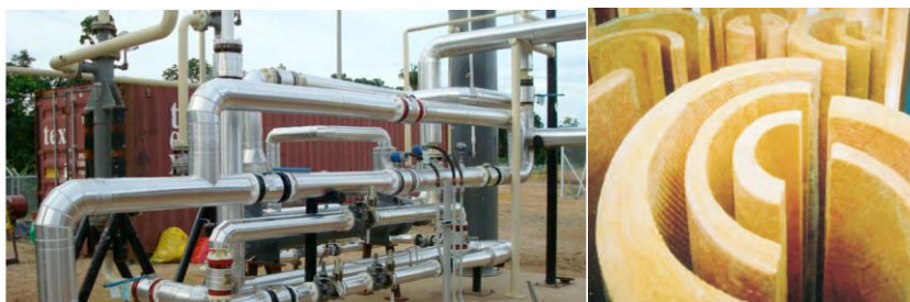
Ilustración 18. Aislamiento térmico Lana de vidrio para tuberías con Cañuelas Alto rango.
