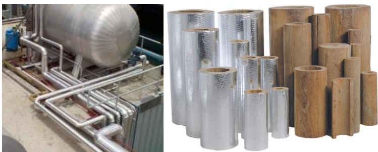
Ilustración 19. Aislamiento Lana de mineral de roca.
