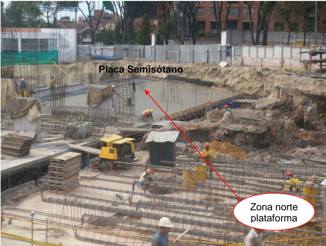
Zona norte plataforma
