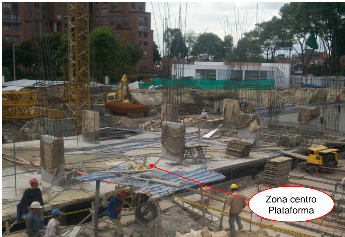
Zona centro plataforma
