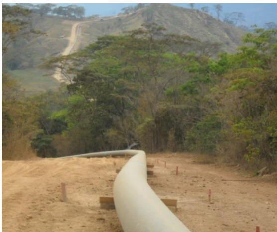
Figura 8 Línea de flujo en construcción en el campo de Floreña.
