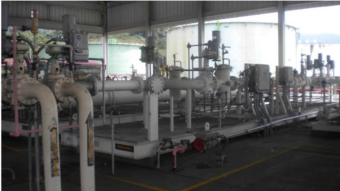
Figura 7 Unidad de Fiscalización de la Estación de Puerto Salgar.
