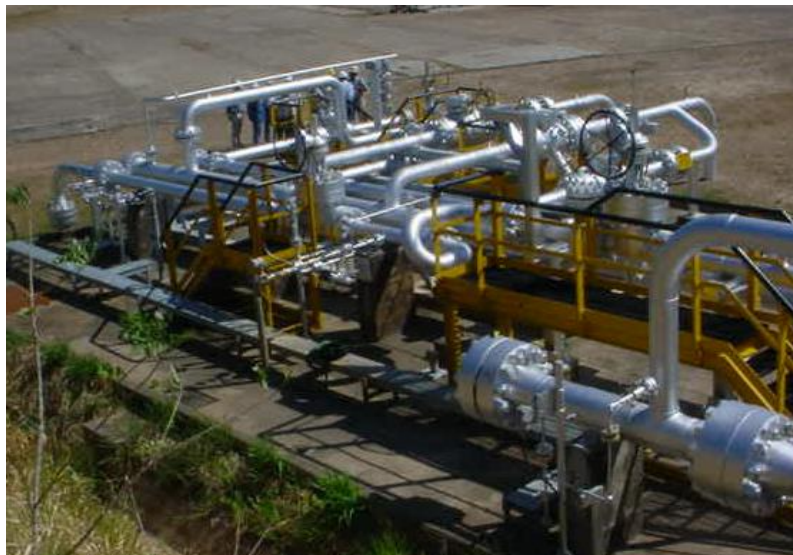
Figura 3 Manifold en plataforma ubicada en el Campo de Cusiana.
