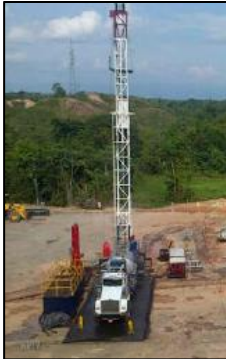
Figura 21. Mástil apoyado sobre la plataforma del camión
