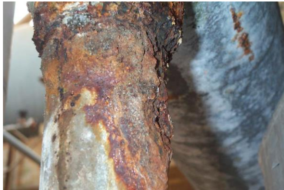
Figura 26. Acercamiento a Tee después de la remoción del aislamiento
