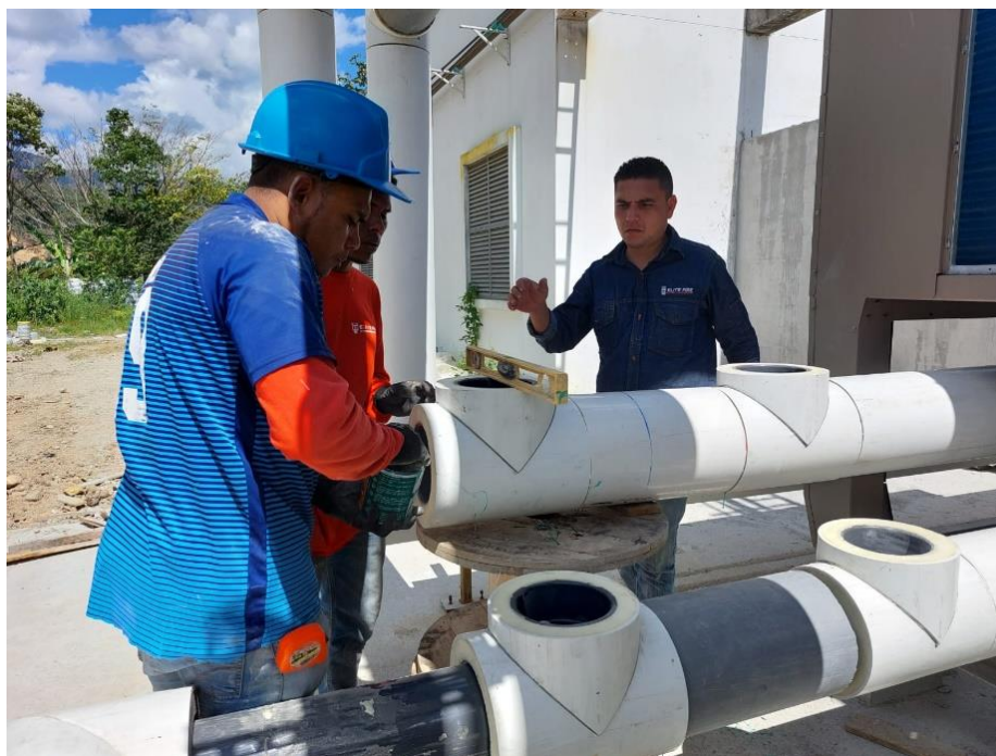
Figura 34 Instalación de tubería pre-aislada de 6" del Chiller tipo tornillo
