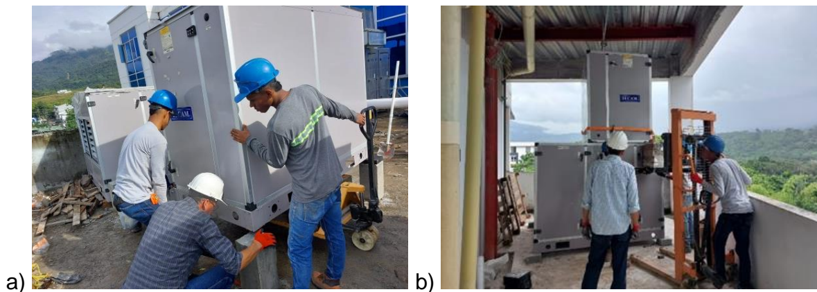
Figura 21 Posicionamiento y acople de equipos de aire acondicionado
