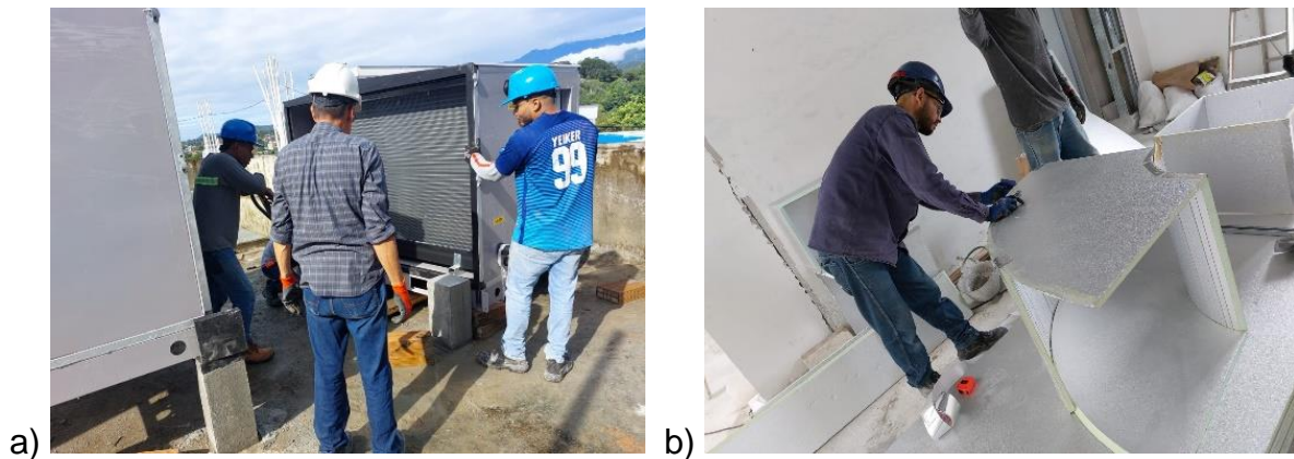
Figura 35 a) Frente 2 realizando la Ubicación y acople de equipos, b) Frente 1 realizando la fabricación de ductos de PIR.ALU.
