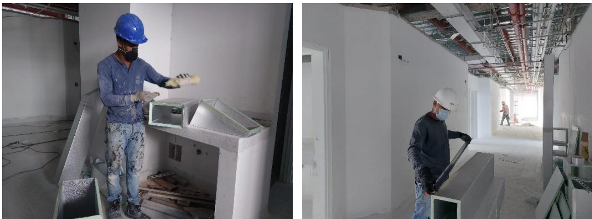
Figura 37 Fabricación de conductos de poli-isocianurato, uso de tapabocas debido al polvo que se encontraba en el área de trabajo.
