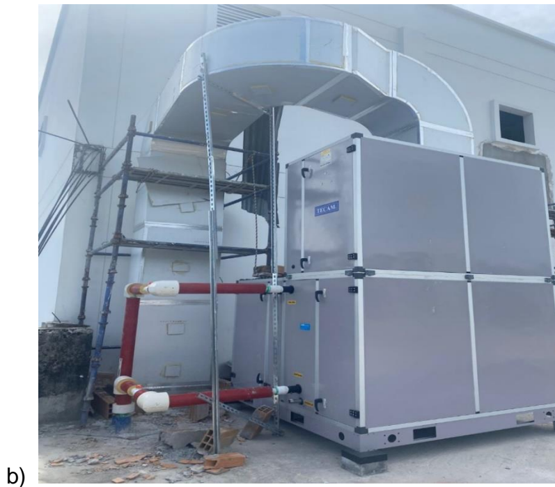
Figura 28 a) Localización de unidad manejadora de medicina interna en plano de 5to piso hospitalización; b) ubicación final de la Unidad Manejadora de Medicina Interna.
