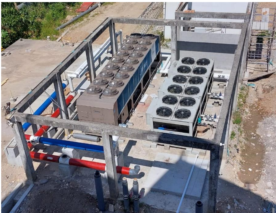
Figura 33 Ubicación final en obra de Chiller tipo tornillo marca MIDEA.
