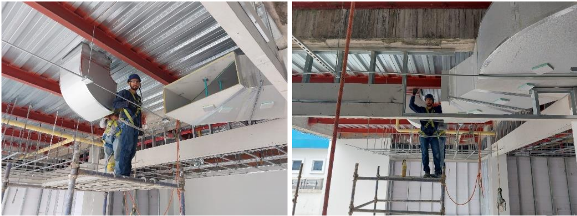
Figura 36 Trabajo en altura realizado por el Frente 1, actividad de subida de ductos del piso 2 a piso 3 de consulta externa.
