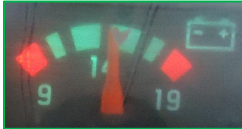
Figura 32. Amperímetro del motor.
