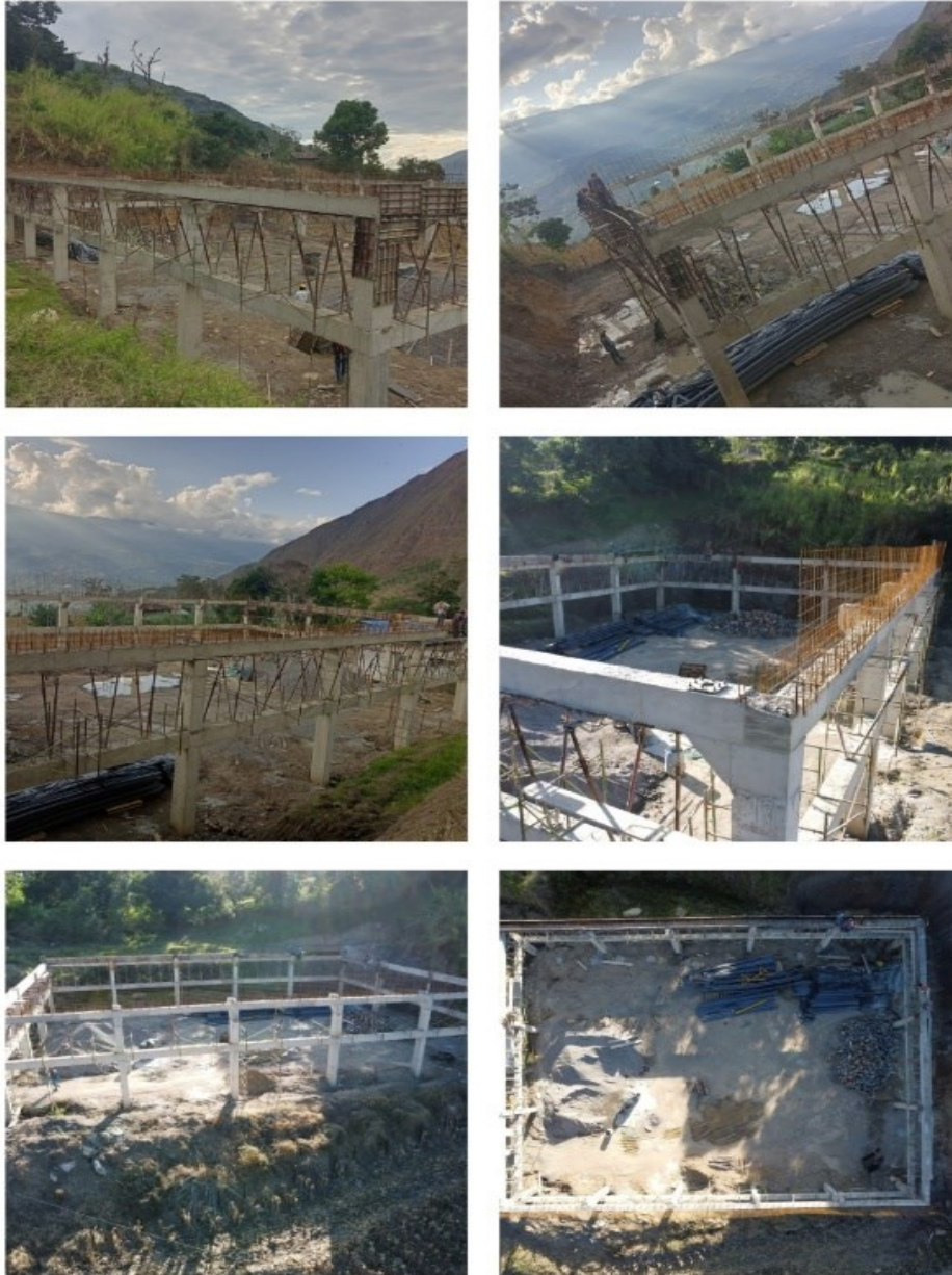
Figura 14. Terminación de estructura en concreto.
