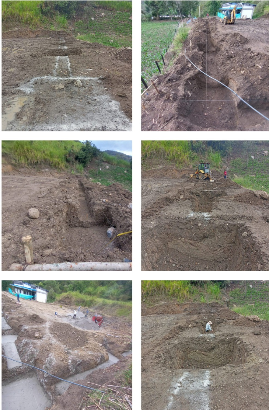
Figura 10. Nivelación del terreno y excavaciones.
