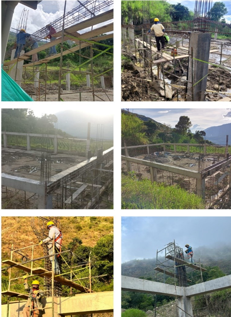
Figura 13. Armado de estructura horizontal del coliseo.
