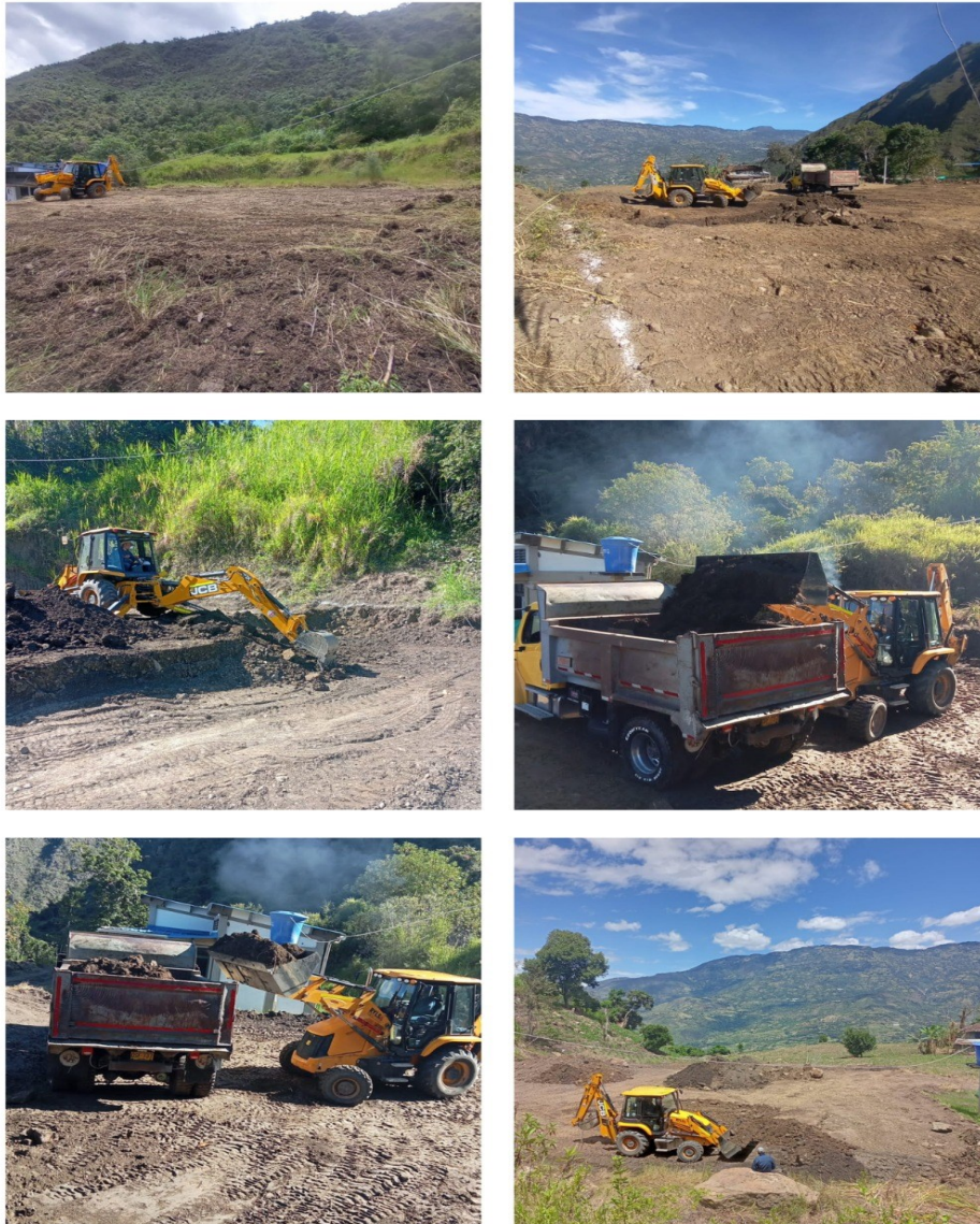
Figura 9. Actividad de descapote y retiro de material
