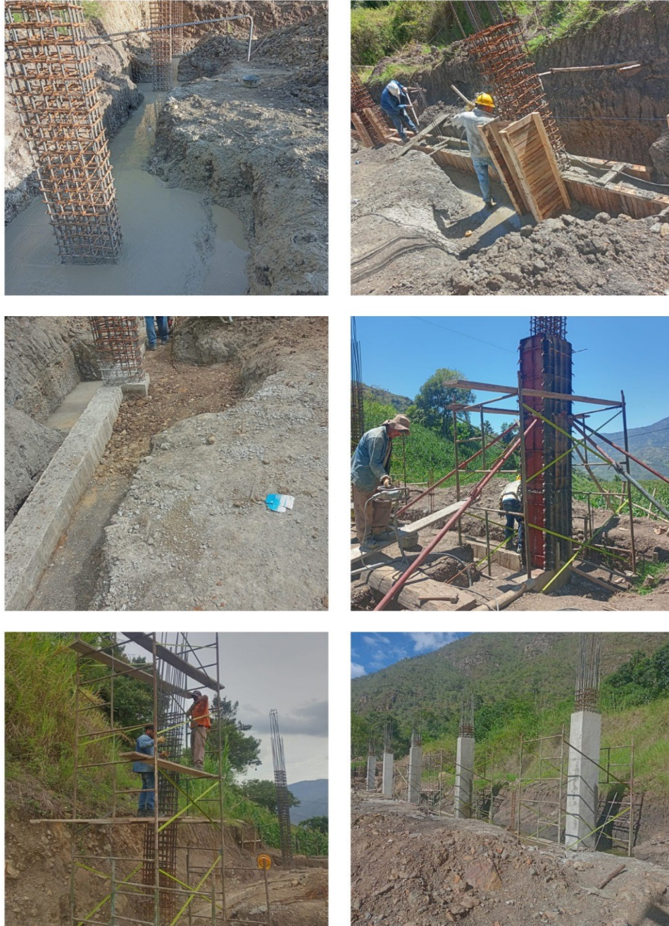
Figura 12. Fundida de zapatas, viga de cimentación y columnas.
