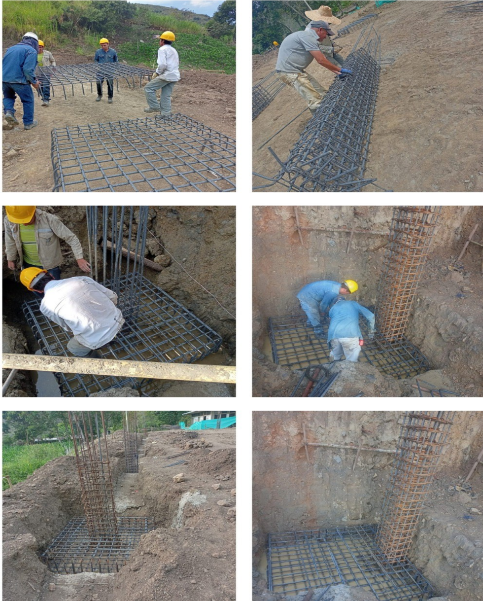
Figura 11. Armado de aceros de zapatas y columnas.
