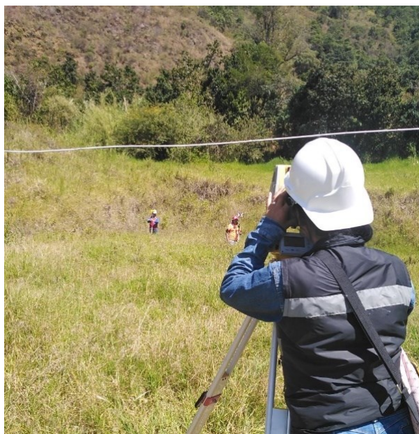
Figura 4. Realización de levantamiento topográfico.
