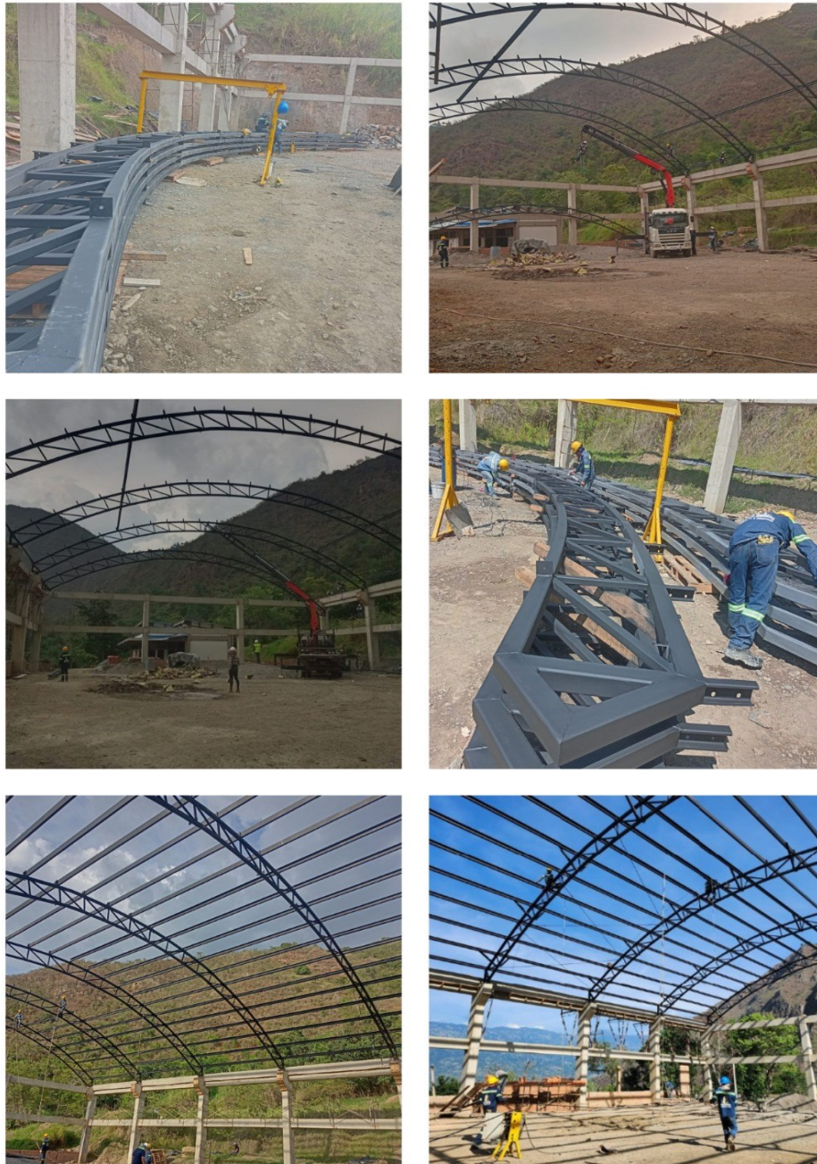
Figura 15. Proceso de montaje de la estructura metálica.
