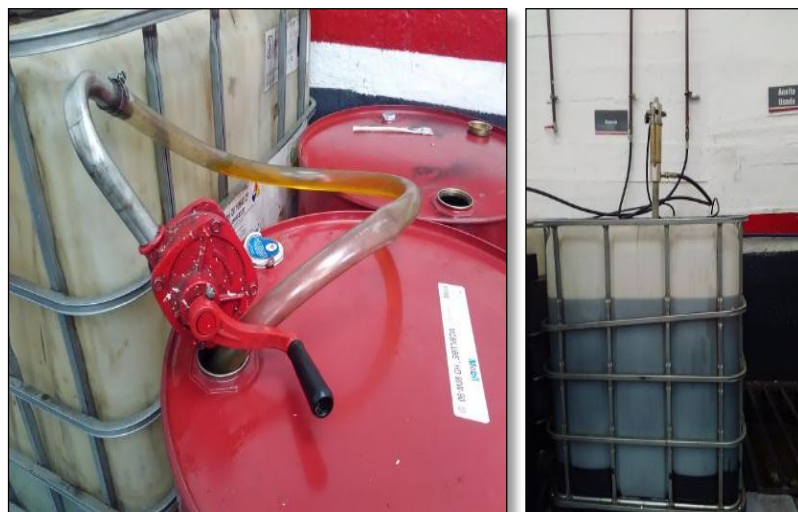
Figura 8. Centro de acoplamiento de distribución de aceite
