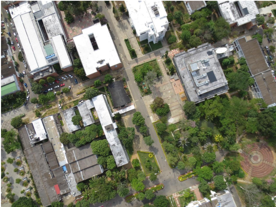
Figura 14: Vista aérea edificio mecánica
