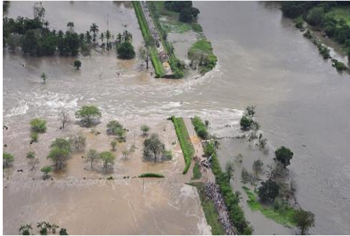
Figura 7. Inundaciones por fallas de Infraestructura hidráulicas.
