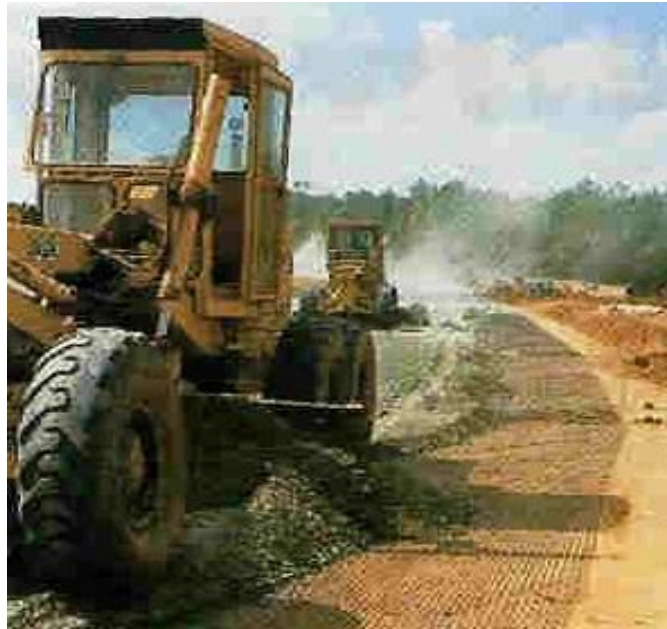
Figura 27. Equipo de Motoniveladora 48(1)
