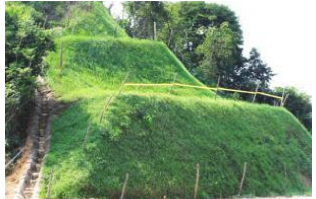
4. Estabilizacion de taludes
