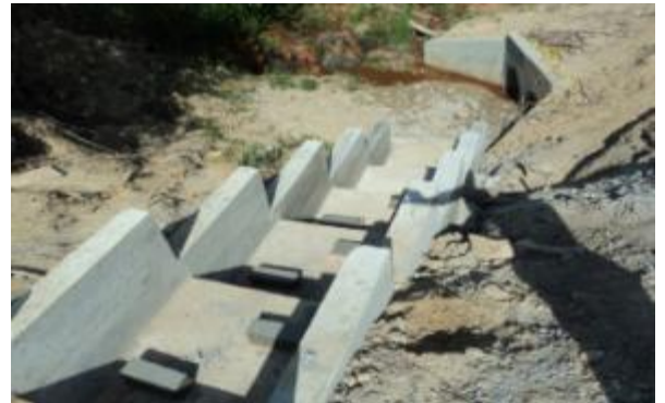
2. Disipador de energía en concreto
