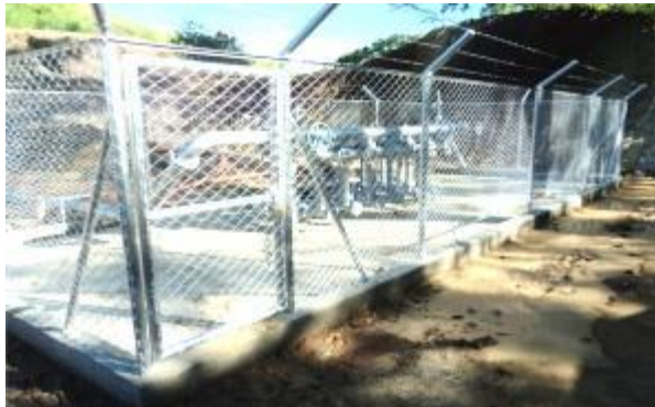
1. Cerramiento en malla eslabonada
