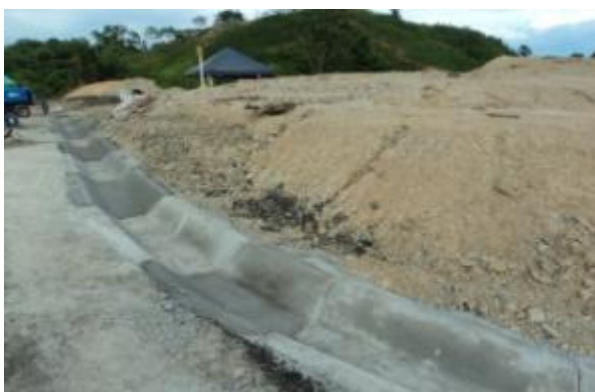
3. Cunetas Trapezoidales en concreto
