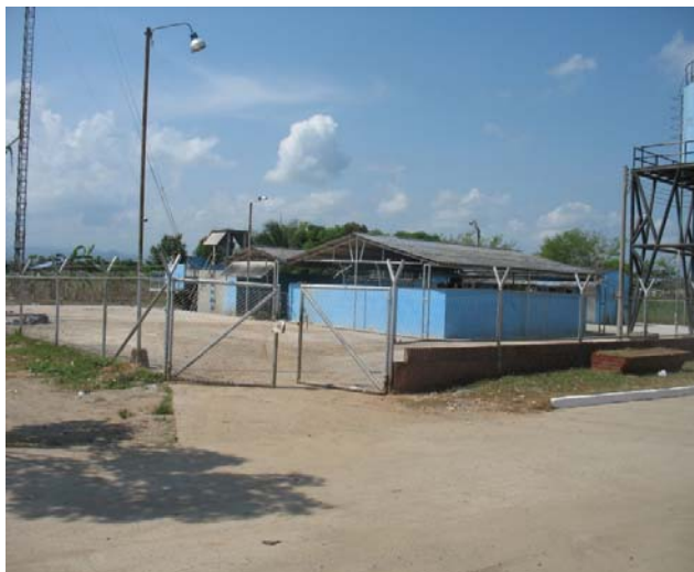
Figura 4. Vista de la Planta de Tratamiento de Agua Potable del Municipio de Cantagallo y Su área Administrativa
