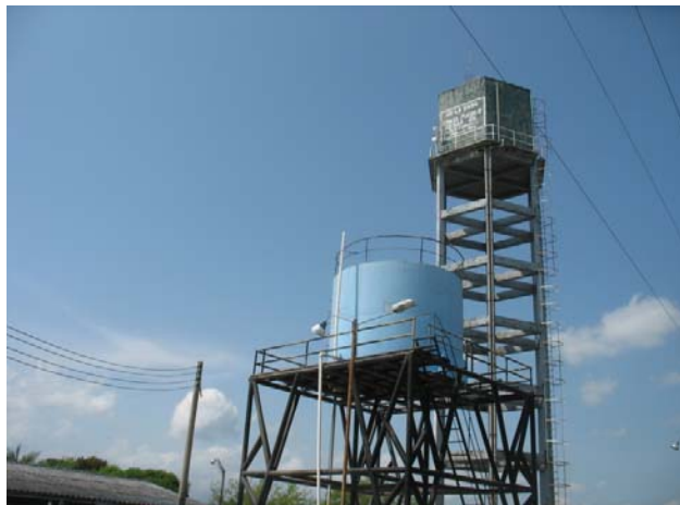
Figura 5. Vista el Tanque de Almacenamiento de Agua Potable
