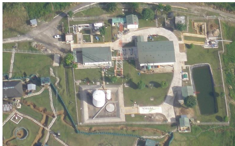
Figura 11. Fotografía aérea de la Planta Guamuez
