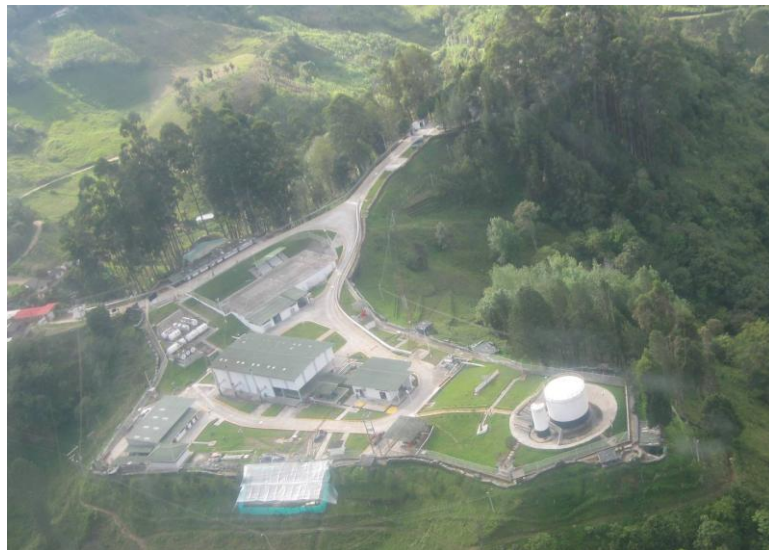
Figura 12. Fotografía aérea de la Planta Alisales
