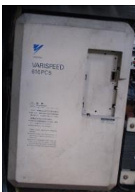
Figura 22. Variador de velocidad
