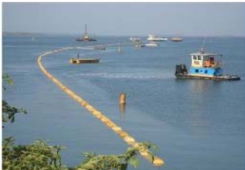
Ilustración 4. Lanzamiento de líneas Ilustración 5. Pilotajes
