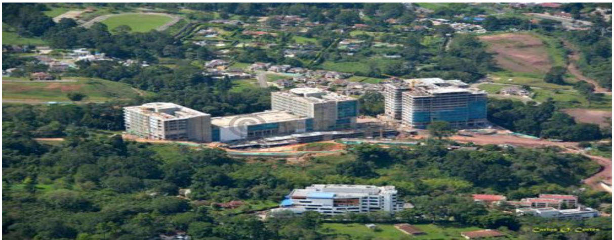
Figura 5. Foto construcción Hospital Internacional de Colombia HIC
