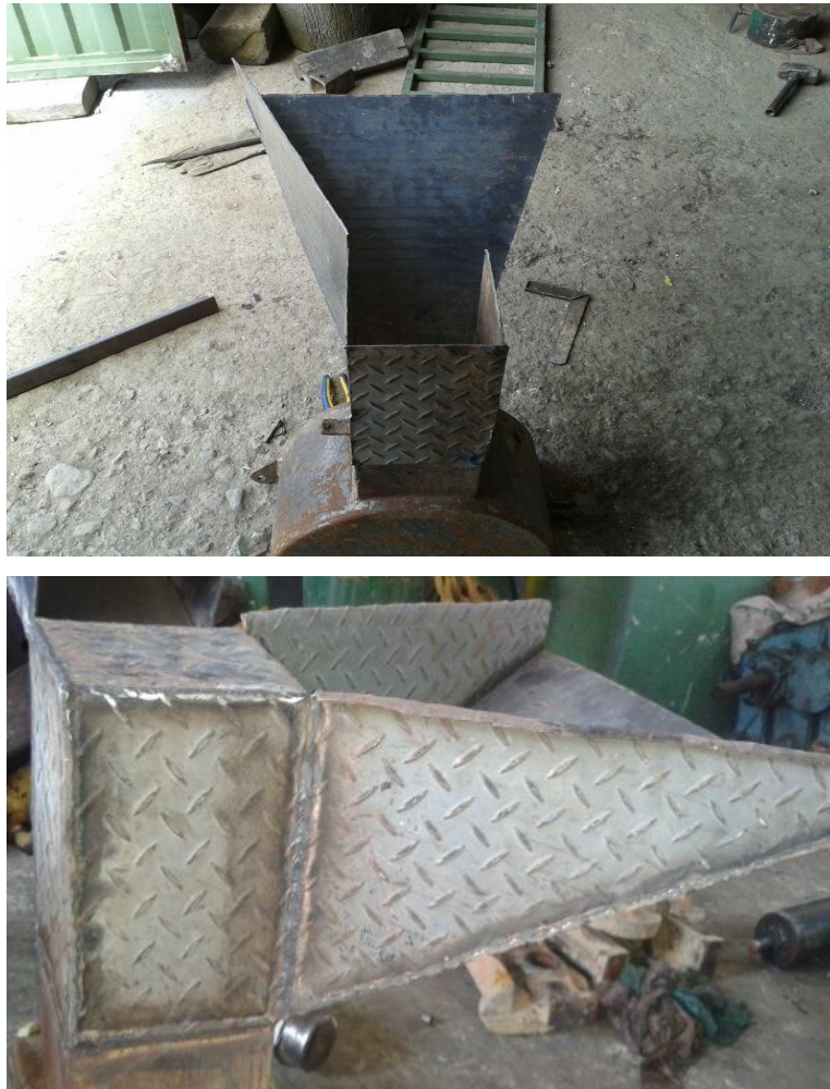
Figura 58. Tolva de Entrada de Material
