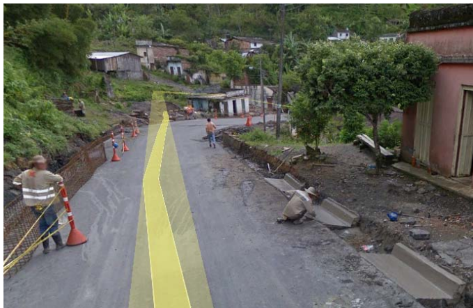
Figura 14. Mantenimiento vía, mayo 2014.
