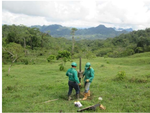
Figura 40. Vista sondeo 5, equipo manual, localizado sobre ladera hacia la parte sur del nuevo Colegio Agrícola de Alto Jordán.
