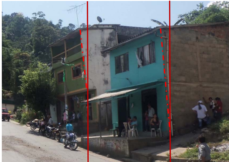
Figura 7. Vista frontal viviendas localizadas en la parte central del corregimiento de Alto Jordán.
