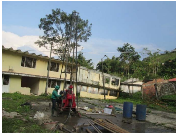
Figura 36. Vista sondeo No.1 predio antiguo Colegio Agrícola de Alto Jordán
