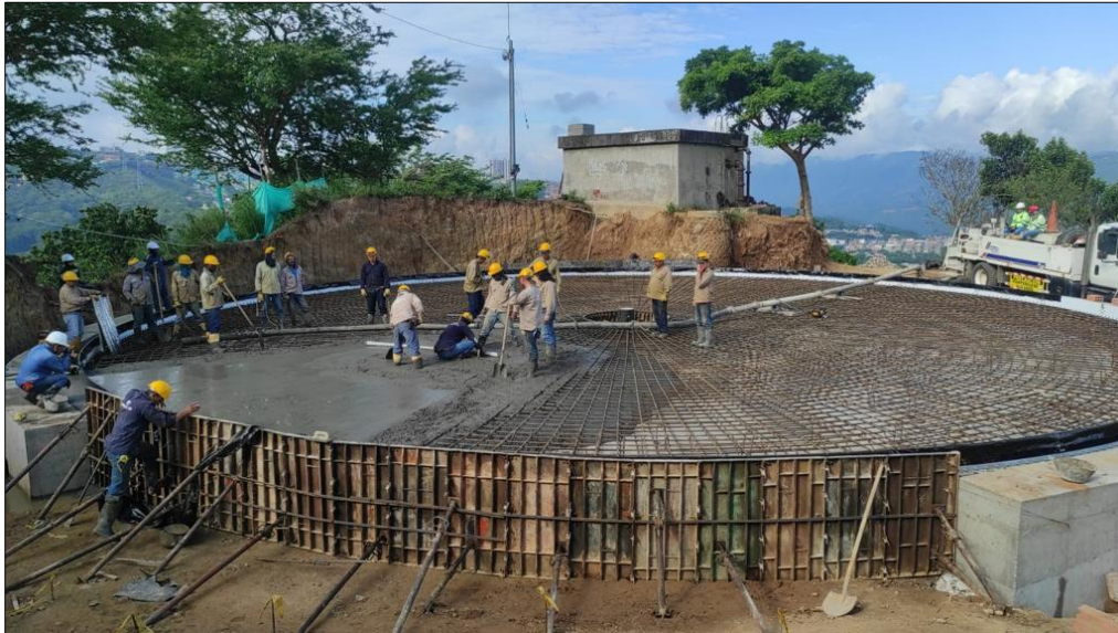
Figura 30. Fundida placa de cimentación.
